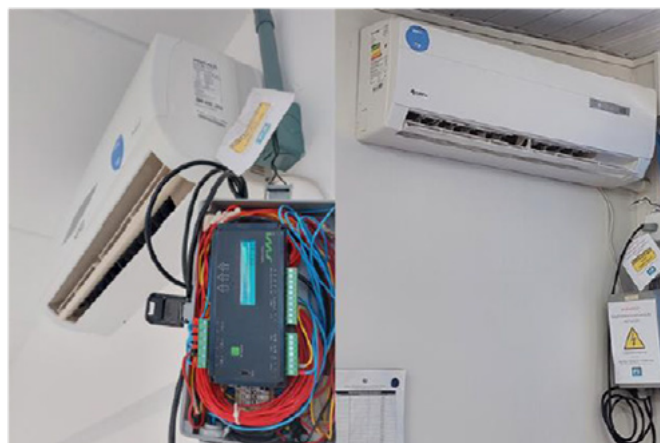
Figura 3. Medição em condicionador de ar. Fonte: Os autores, 2024.
